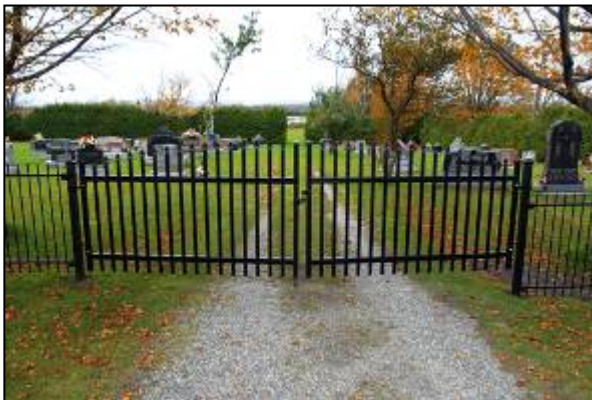
Vantaux et clôture métallique aménagés sur la façade avant du cimetière Saint-Luc, Coaticook (Barnston) (COA-02).
