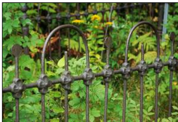
Détail de la clôture de fonte. ► Ward Cemetery, Dixville (DIX-02).
