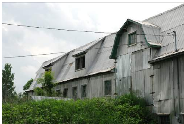
141. Garnaud composé d'une lucarne à deux versants droits, visible au 151, chemin Ives Hill, Compton (COM-003).
