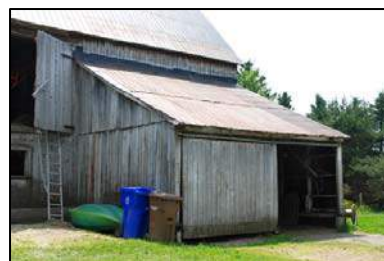
Annexe en appentis
