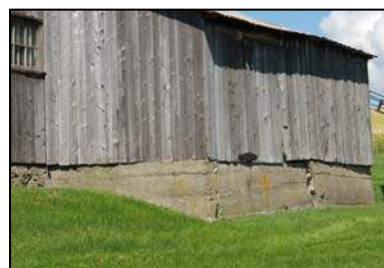
Solage de béton
