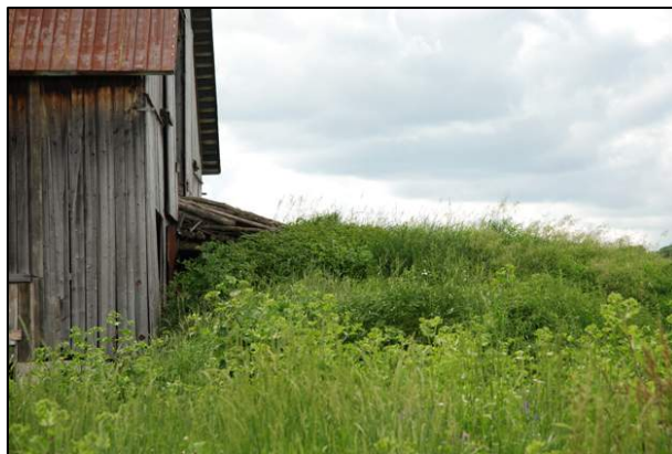
122. Pont d'accès visible au 596, chemin Cotnoir, Coaticook (COK-004).
