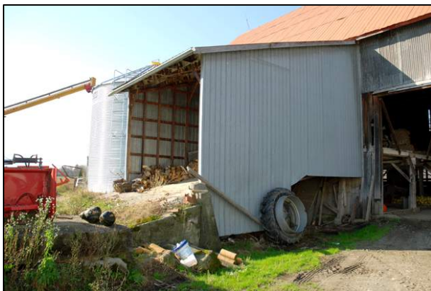
137. Garnaud ajouté ultérieurement à la structure principale, coiffé d'une toiture en appentis et recouvert de feuilles de tôle profilée, situé au 3900, route 143, Waterville (WAT-002).
