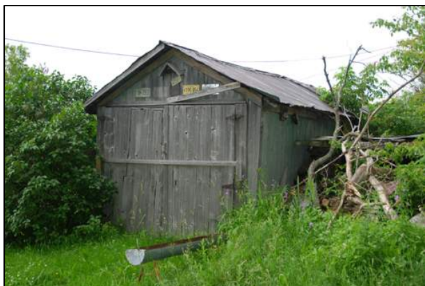
238. Garage/remise situé au 2367, chemin Jordan, Barnston-Ouest (BAO-009).
