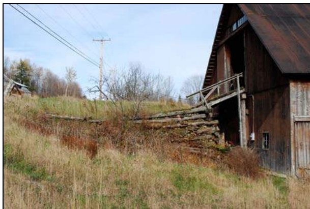
121. Pont d'accès visible sur la route 147, Dixville (DIX-003).
