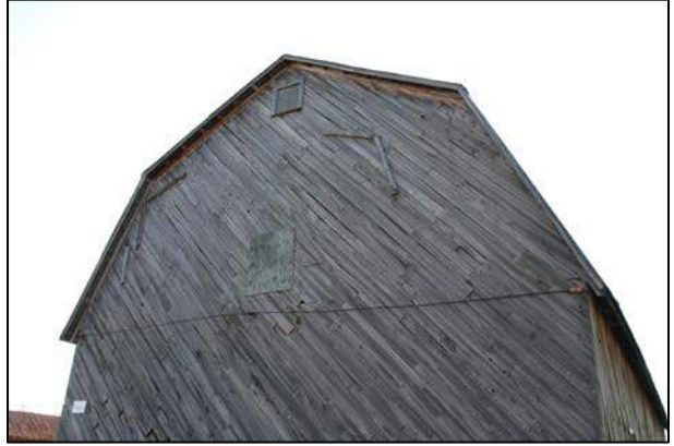
170. Les équerres, qui sont toujours visibles sur la façade latérale gauche de la grange-étable située au 477, chemin Cochrane, à Compton (COM-001), témoignent de l'emplacement occupé à l'origine par les deux silos de bois.
