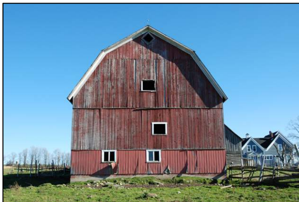
41. Grange-étable située au 768, route 141, Barnston-Ouest (BAO-003).
