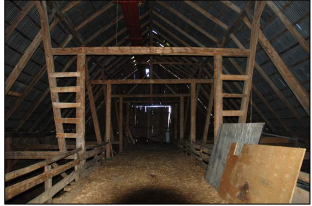
91. Batterie visible à l'intérieur de la grange-étable située au 1215, chemin Perreault, Compton (COM-005).
