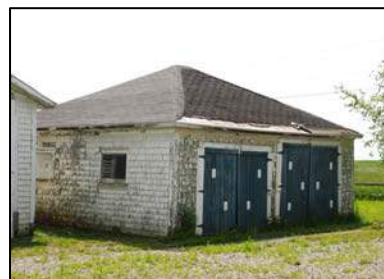
Toiture à quatre eaux
