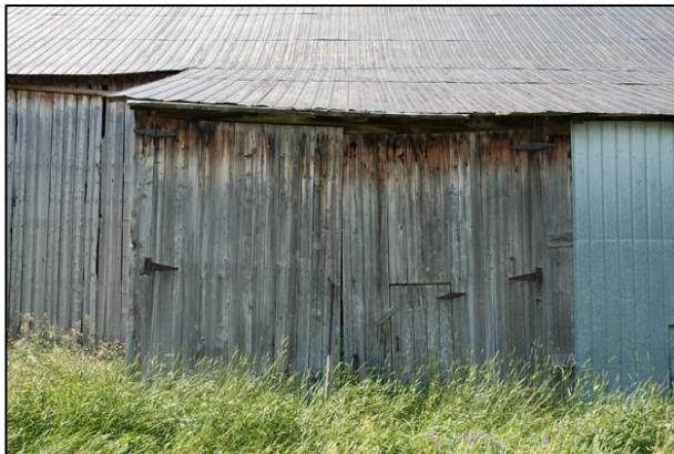
101. Porte à deux battants comportant une ouverture de plus petite dimension, visible au 625, chemin de Moe's River, Compton (COM-009).
