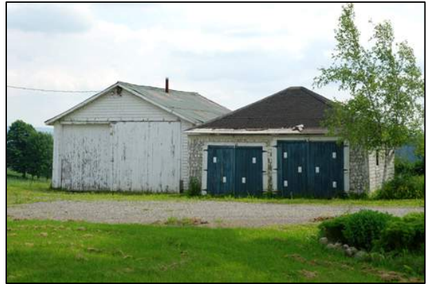
243. Garages/remises situés au 2880, chemin de Fairfax, Stanstead-Est (STA-004).
