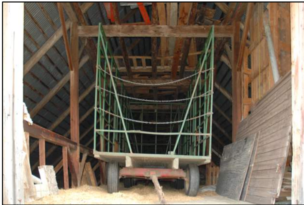
92. Batterie visible à l'intérieur de la grange-étable située sur la route 147, Dixville (DIX-003).
