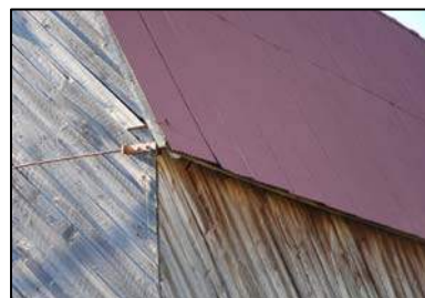
Tôle profilée sur le toit
