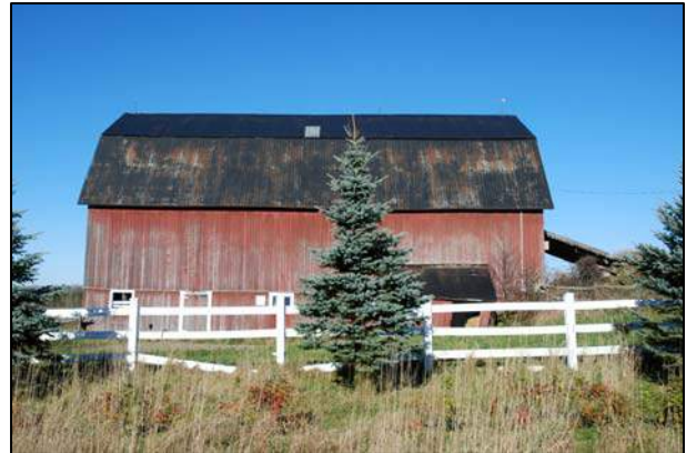
129. Pont d'accès visible au 768, route 141, Barnston-Ouest (BAO-003).
