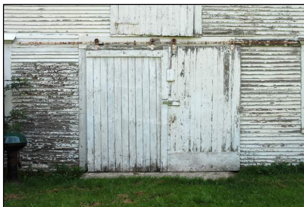
107. Porte coulissante visible au 2880, chemin de Fairfax, Stanstead-Est (STA-004).
