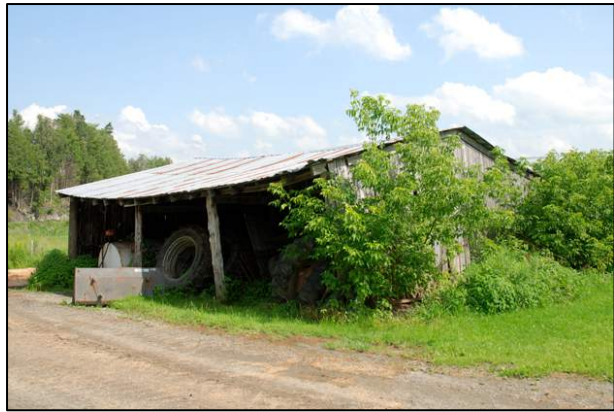
235. Hangar à machineries situé au 155, chemin Flanders, Waterville (WAT-005).
