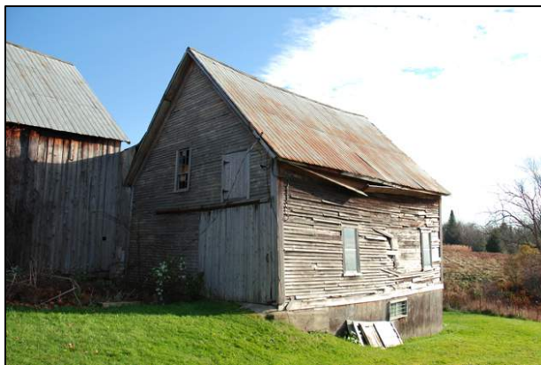
207. Écurie située au 999, route 141, Barnston-Ouest (BAO-004).
