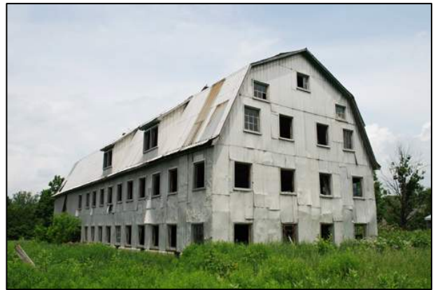
63. Le revêtement en tôle galvanisée de couleur argentée dissimule une structure recouverte en grande majorité de planches de bois apposées obliquement. Grange-étable située au 2103, chemin de Way's Mills, Barnston-Ouest (BAO-014).
