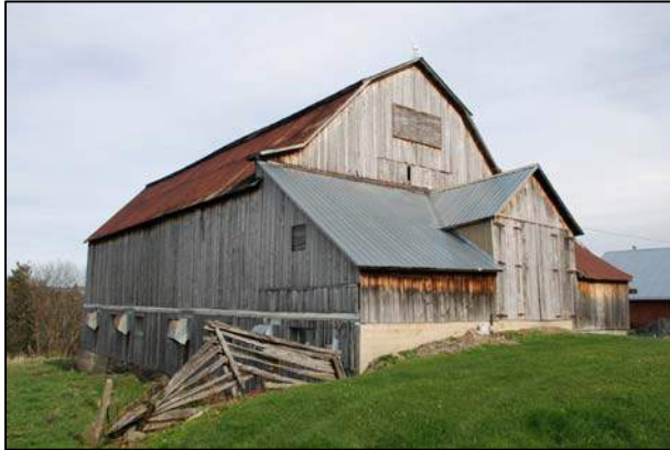
133. Garnaud coiffé d'une toiture à deux versants droits, recouvert de planches de bois apposées verticalement et fermé par une porte à deux battants, situé au 95, chemin Coward, Dixville (DIX-001).
