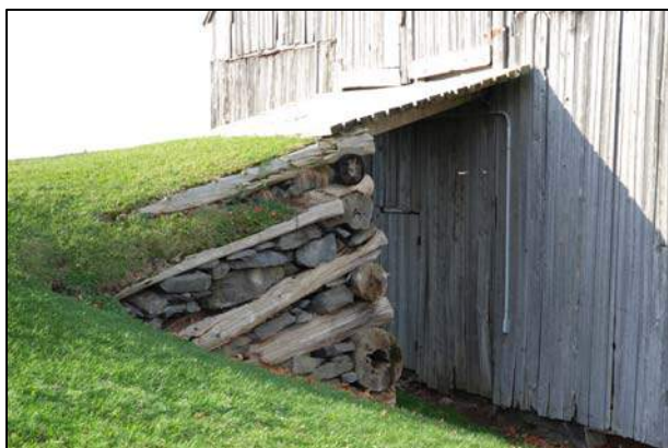
119. Pont d'accès visible au 114, chemin Madore, Barnston-Ouest (BAO-002).
