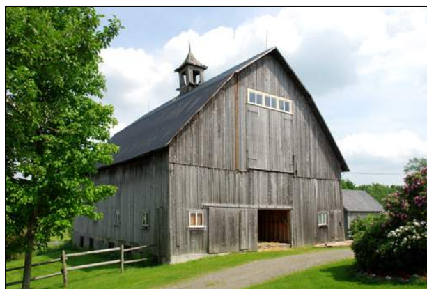
106. Grange-étable combinant sur une même structure une porte coulissante (premier niveau) et une porte à deux battants (espace des combles), visible au 200, chemin Vivian, Stanstead-Est (STA-005).
