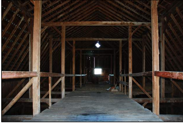
90. Batterie visible à l'intérieur de la grange-étable située au 768, route 141, Barnston-Ouest (BAO-003).
