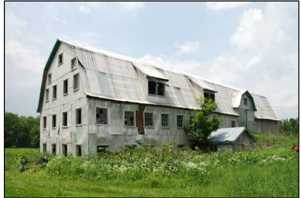
56. Façades avant et latérale gauche de la grange-étable située au 2103, chemin de Way's Mills, Barnston-Ouest (BAO-014).
