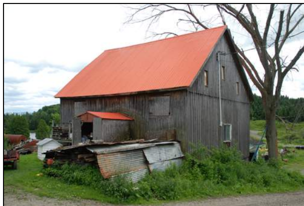
210. Écurie située au 596, chemin Cotnoir, Coaticook (COK-004).
