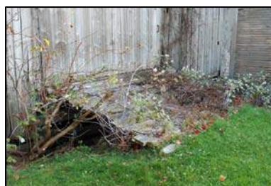
Ponceau de bois
