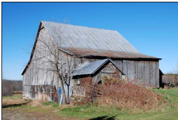
11. Grange-étable située au 2373, chemin Holmes, Barnston-Ouest (BAO-001).
