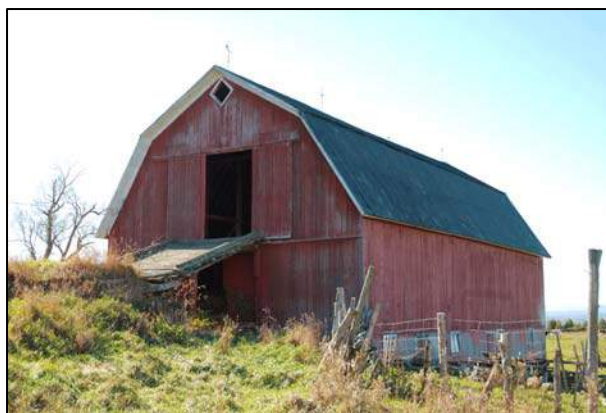
154. Grange-étable située au 768, route 141, Barnston-Ouest (BAO-003).
