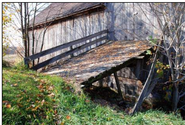
114. Pont d'accès visible au 151, chemin Ives Hill, Compton (COM-003).
