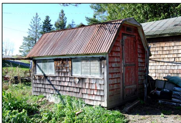
202. Poulailler situé au 2722, chemin de Way's Mills, Barnston-Ouest (BAO-006).
