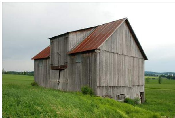
140. Garnaud surmonté d'une lucarne en appentis, visible sur le chemin Vaillancourt, à Compton (COM-013).
