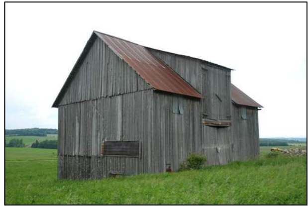
61. Grange-étable située sur le chemin Vaillancourt, Compton (COM-013).
