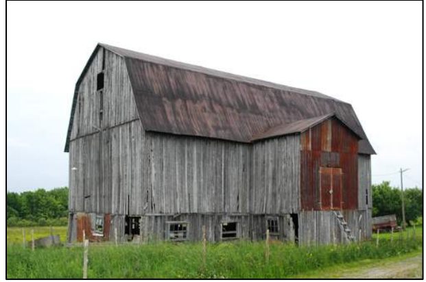
54. Façades avant et latérale droite de la grange-étable située au 92, chemin Saint-Pierre, Martinville (MAR-003).
