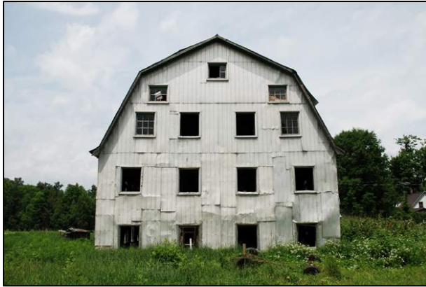
55. Façade latérale gauche de la grange-étable située au 2103, chemin de Way's Mills, Barnston-Ouest (BAO-014).
