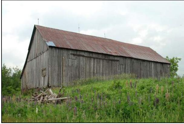
4. Grange-étable située au 2337, chemin Jordan, Barnston-Ouest (BAO-009).
