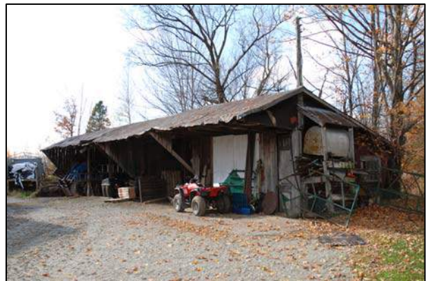
233. Hangar à machineries situé au 224, chemin de Saint-Isidore, Martinville (MAR-002).
