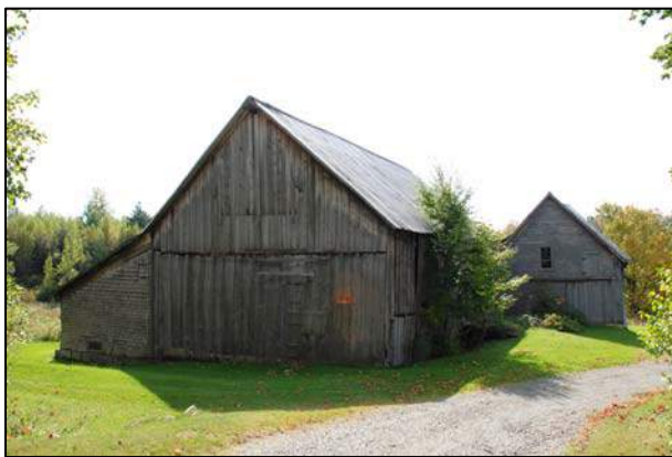
2. Grange-étable située au 999, route 141, Barnston-Ouest (BAO-004).
