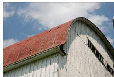
Parement en couvre-joint
