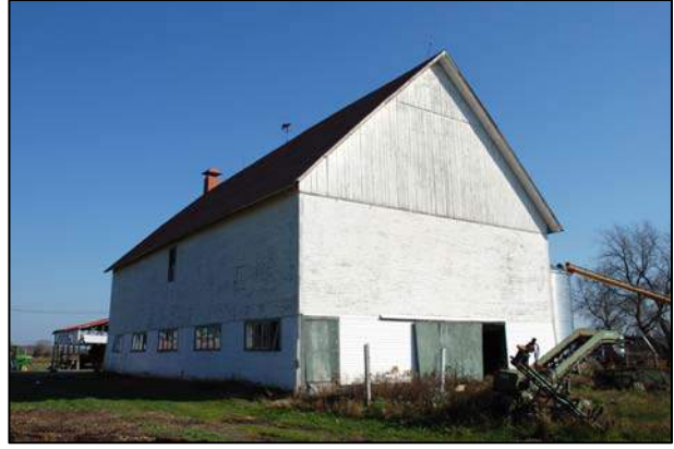
88. Grange-étable située au 3900, route 143, Waterville (WAT-002).
