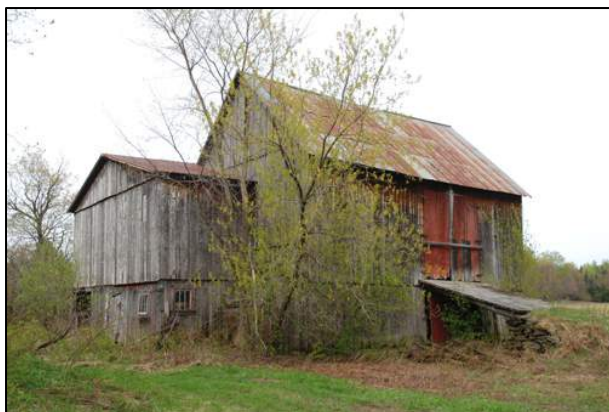
15. Grange-étable située au 2412, chemin Jordan, Barnston-Ouest (BAO-010).
