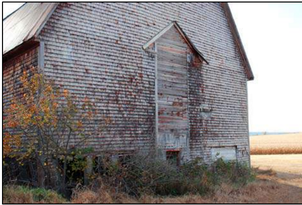
171. La façade gauche de la grange-étable située au 41, chemin de Moe's River, à Compton (COM-004), porte encore à ce jour les traces de la présence d'un silo de bois à cet endroit.
