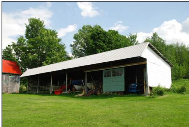
234. Hangar à machineries situé au 2485, chemin Curtis, Stanstead-Est (STA-002).
