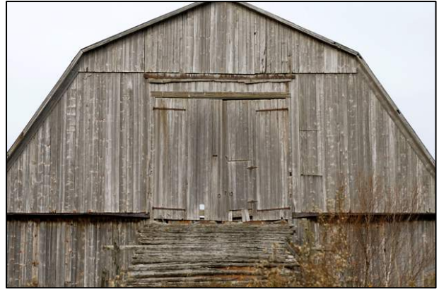
100. Porte à deux battants comportant une ouverture de plus petite dimension, visible au 1013, chemin Beloin, Coaticook (COK-001).
