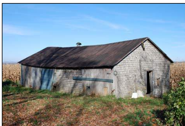
227. Hangar à machineries situé au 325, chemin Vaillancourt, Compton (COM-006).
