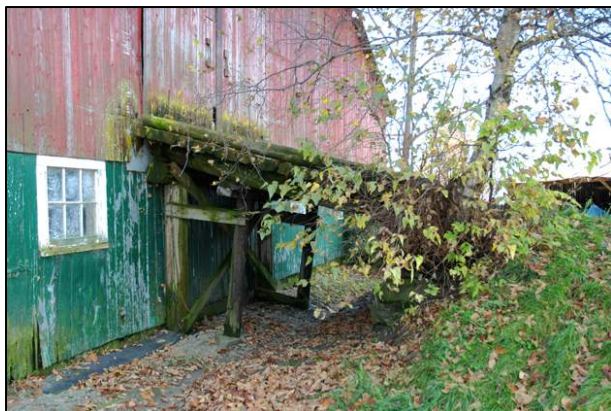
117. Pont d'accès visible 224, chemin de Saint-Isidore, Martinville (MAR-002).
