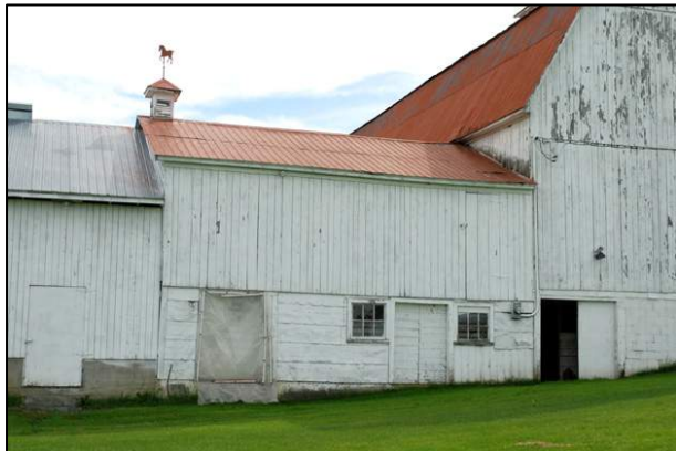
193. Cette laiterie, qui comporte sur la partie arrière de sa toiture un évent de toiture surmonté d'une girouette, s'adosse sur la façade arrière de la grange-étable située au 305, chemin Robert, Compton (COM-001).
