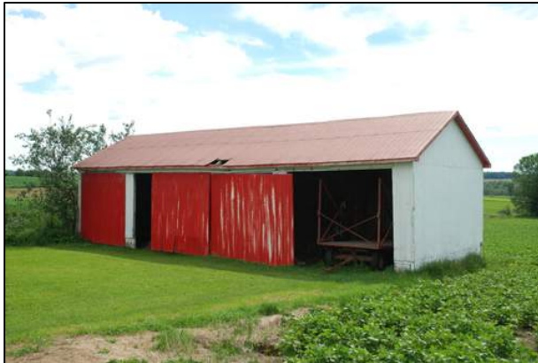
230. Hangar à machineries situé au 310, chemin Vaillancourt, Compton (COM-012).
