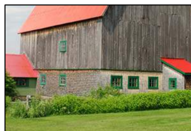
Chambranles autour des ouvertures
