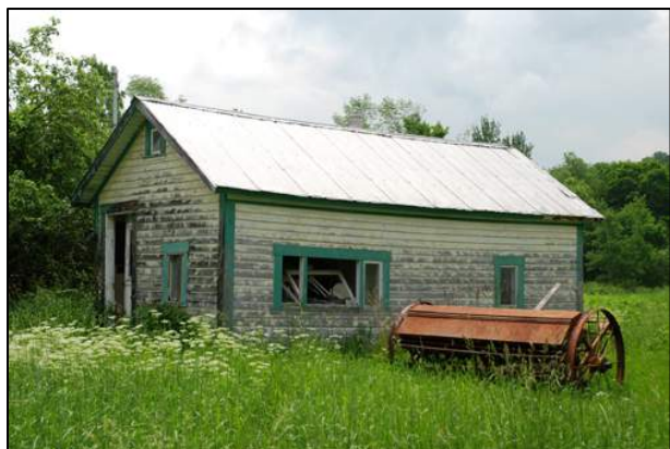
239. Garage/remise situé au 2103, chemin de Way's Mills, Barnston-Ouest (BAO-014).
