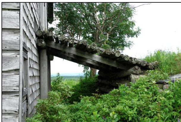
113. Pont d'accès visible au 1375, chemin Devost, Coaticook (COK-005).
