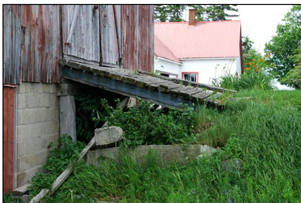
115. Pont d'accès visible au 310, chemin Vaillancourt, Compton (COM-012).
