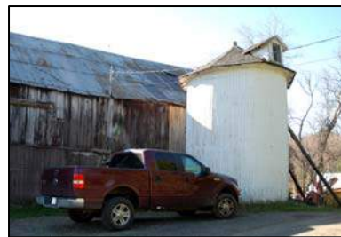
Silo de bois de forme cylindrique
