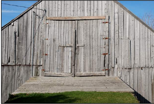
99. Porte à deux battants comportant une ouverture de plus petite dimension, visible au 114, chemin Madore, Barnston-Ouest (BAO-002).
