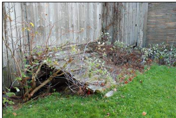
109. Ponceau visible au 999, route 141, Barnston-Ouest (BAO-004).
