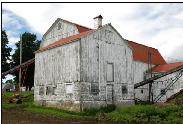
221. Hangar à grains s'élevant en retrait de la grange-étable située sur le chemin Robert, Compton (COM-011).
