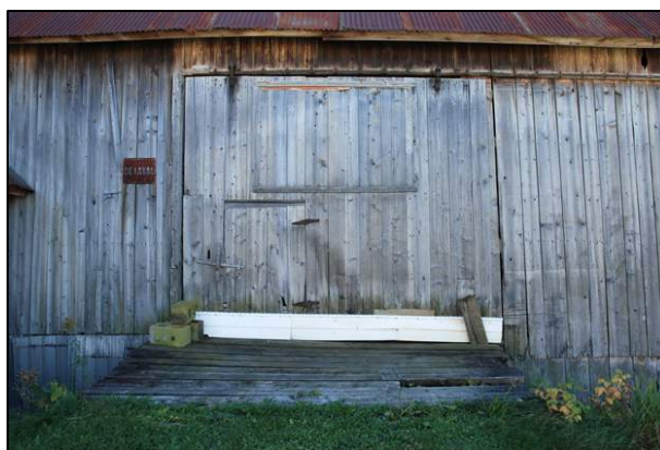
105. Porte coulissante comportant une ouverture à échelle humaine, visible au 165, chemin du 5 e Rang, Saint-Malo (STM-001).
