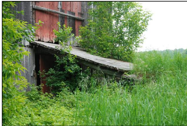
112. Pont d'accès visible au 2412, chemin Jordan, Barnston-Ouest (BAO-010).
