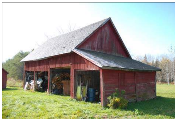
68. Hangar à machineries situé au 341, chemin Loignon, Martinville (MAR-001).
