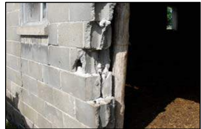
Mur en blocs de béton
