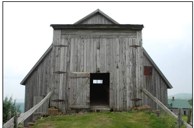
102. Porte à deux battants comportant en son centre une ouverture de plus petite dimension, visible au 560, chemin du 3 e Rang, Dixville (DIX-004).
