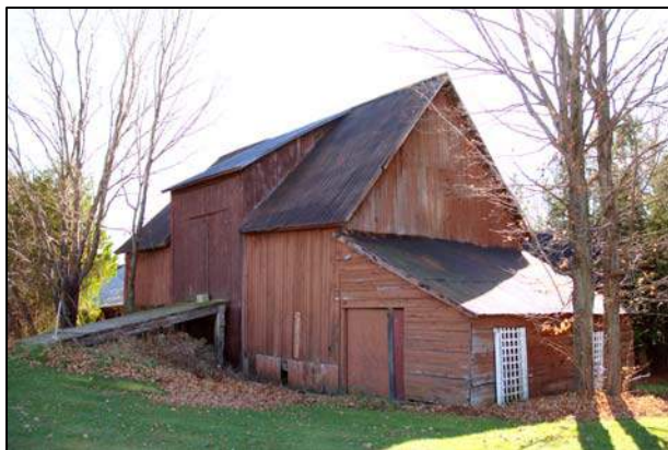
139. Garnaud composé d'une lucarne en appentis, visible au 2850, chemin de Way's Mills, Barnston-Ouest (BAO-007).
