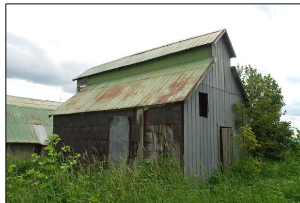
222. Construit possiblement après les années 1952, ce hangar à grains est situé sur le chemin Buckland, Barnston-Ouest (BAO-008).
