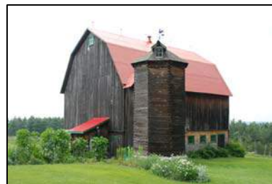
Silo de bois de forme octogonale
