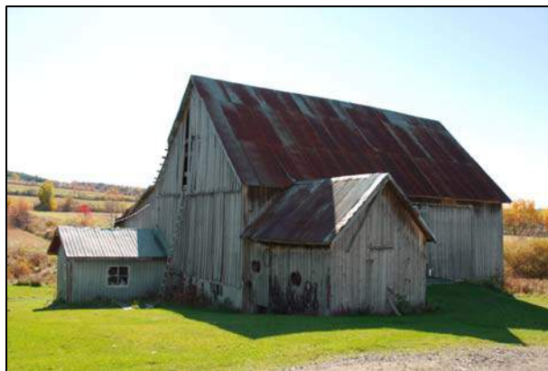
12. Grange-étable située au 165, chemin du 5 e rang, Saint-Malo (STM-001).
