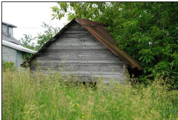
175. Laiterie située au 2367, chemin Jordan, Barnston-Ouest (BAO-009).
