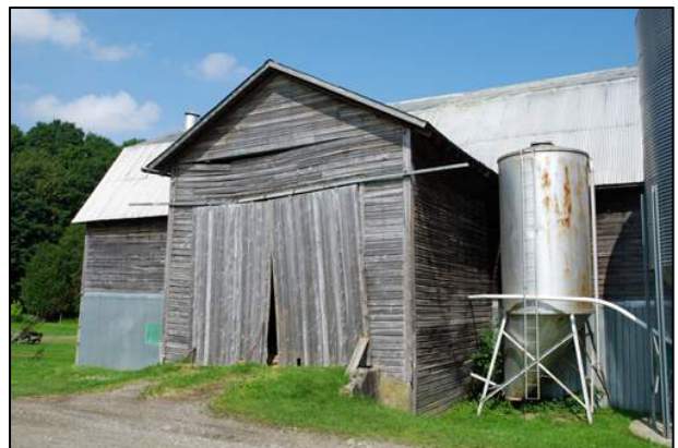
138. Garnaud surmonté d'une toiture à deux versants, recouvert de planches à feuillures disposées horizontalement et fermé par deux portes coulissantes, situé au 155, chemin Flanders, Waterville (WAT-005).
