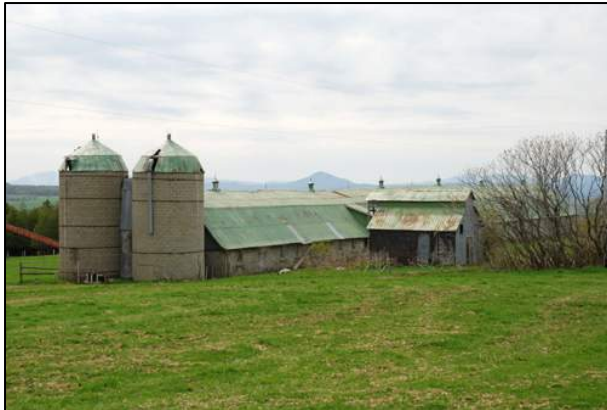
166. Grange-étable située sur le chemin Buckland (face au n° 325), Barnston-Ouest (BAO-008).
