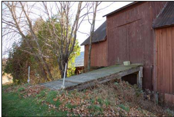
111. Pont d'accès visible au 2850, chemin de Way's Mills, Barnston-Ouest (BAO-007).
