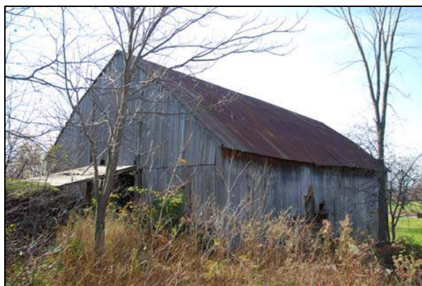
126. Pont d'accès de la grange-étable située au 300, route 143, Stanstead- Est (STA-001).
