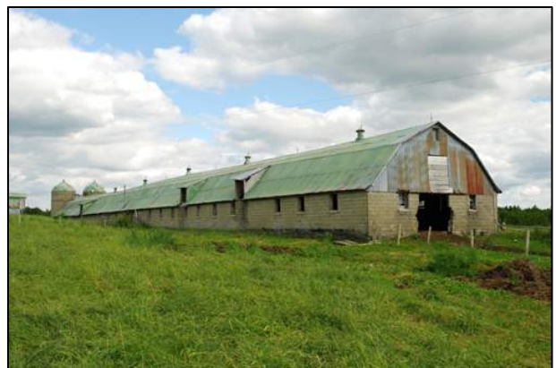
58. Façades avant et latérale droite de la grange-étable située sur le chemin Buckland, Barnston-Ouest (BAO-008).
