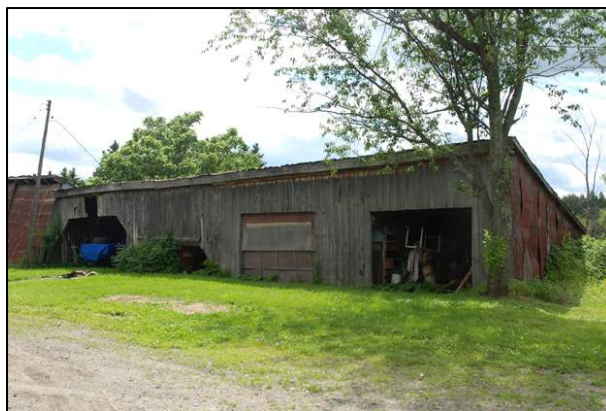
225. Hangar à machineries situé au 596, chemin Cotnoir, Coaticook (COK-004).
