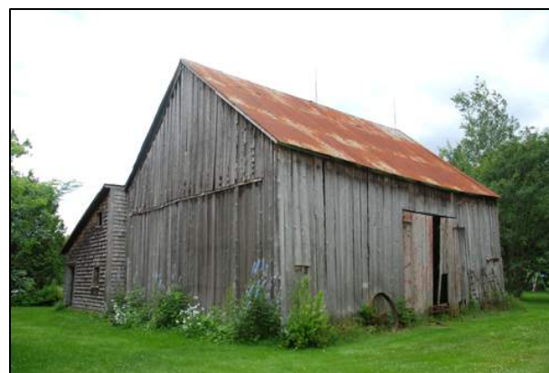
14. Grange-étable située au 639, chemin Stage, à Barnston-Ouest (BAO-012).
