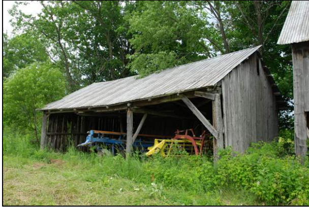
228. Hangar à machineries situé au 495, chemin des Chênes, Compton (COM-008).
