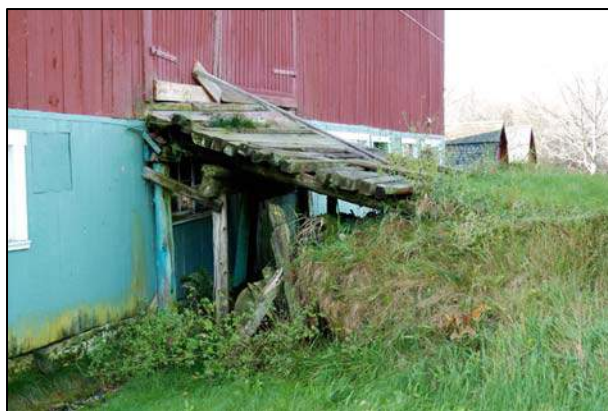
116. Pont d'accès visible au 341, chemin Loignon, Martinville (MAR-001).
