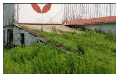
Rampe d'accès en béton
