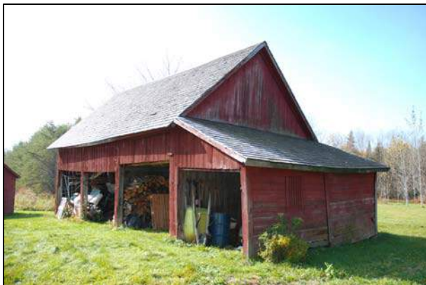
232. Hangar à machineries situé au 341, chemin Loignon, Martinville (MAR-001).
