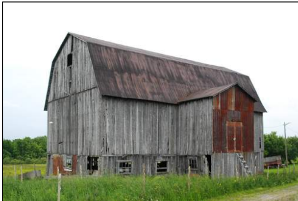
135. Garnaud surmonté d'une toiture à deux versants, recouvert de planches de bois apposées verticalement et fermé par une porte à deux battants, situé au 92, chemin Saint-Pierre, Matinville (MAR-003). Le pont d'accès a été dématelé au cours des dernières décennies.
