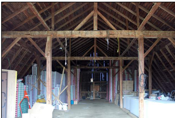
94. Batterie visible à l'intérieur de la grange-étable située au 105, chemin de Stanhope-Baldwin, Dixville (DIX-006).
