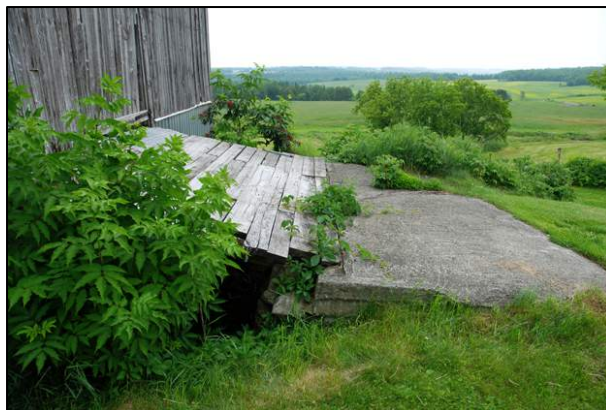
110. Ponceau visible au 495, chemin des Chênes, Compton (COM-008).
