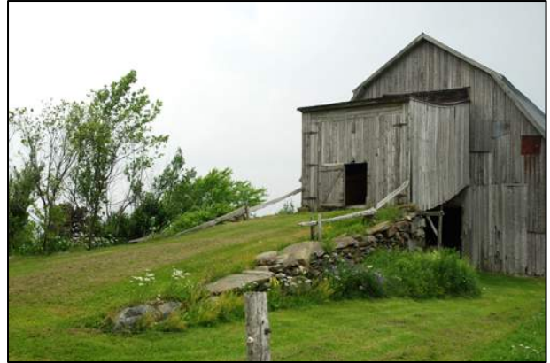
134. Garnaud surmonté d'une toiture en appentis, recouvert de planches de bois apposées verticalement et fermé par une porte à deux battants, situé au 560, chemin du 3 e Rang, Dixville (DIX-004).
