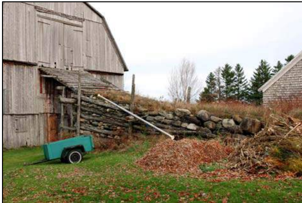
128. Pont d'accès visible au 1013, chemin Beloin, Coaticook (COK-001).
