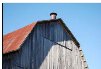
Évents disposés au faîte du bâtiment
