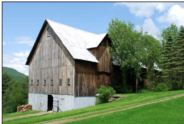
142. Grange-étable comportant deux garnauds (grange à double pont) composés de lucarnes à deux versants droits, visible au 805, chemin de Astbury, Waterville (WAT-004).
