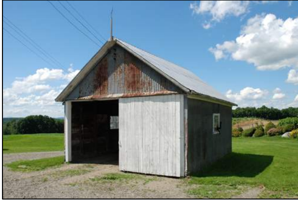
240. Garage/remise situé au 517, chemin Audet, Compton (COM-007).
