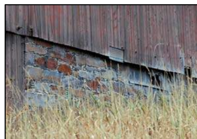
Soubassement en maçonnerie
